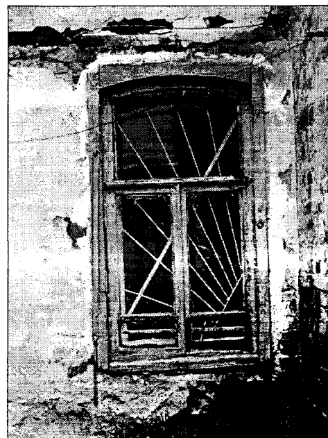
Фото 9 Окно юго-западного фасада
