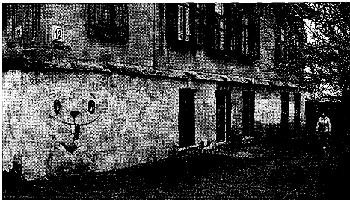
Фото 6 Северо-западный фасад, фрагмент.
